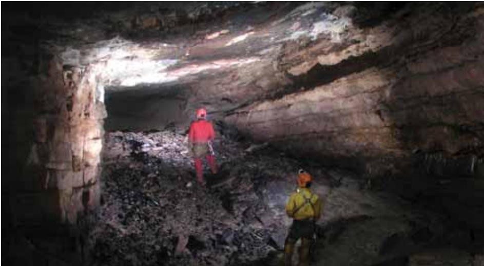
Fig. 7 : Dalles de grès effondrées avant l'ancien siphon de sable. Sur les parois, on peut observer le pendage des couches de calcaires (JYB, 18/08/2016)
