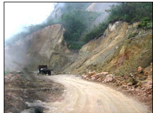
Figure 5 – La « grande route » entre Cobán et Uspatan en cours d'aménagement (photo. Ph. Audra) The « highway » between Cobán and Uspatan, under construction... La « gran carretera » entre Cobán y Uspatan en curso de acondicionamiento
