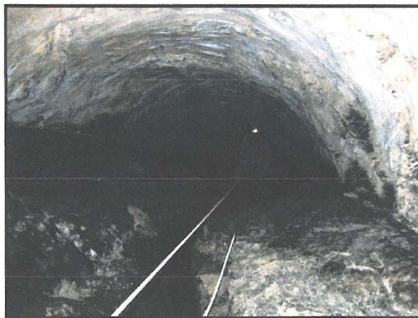
Conduite forcée surcreusée dans le système Eléna- Tantanavé
