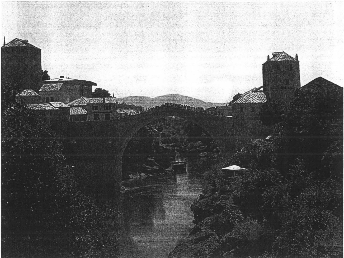
Le célèbre PONT DE MOSTAR reconstruit
