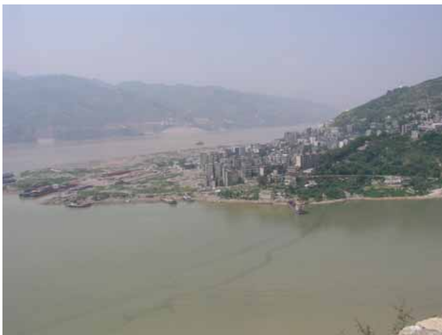
Les derniers bâtiments en cours de démolition de la « vieille ville » de Fengjie
