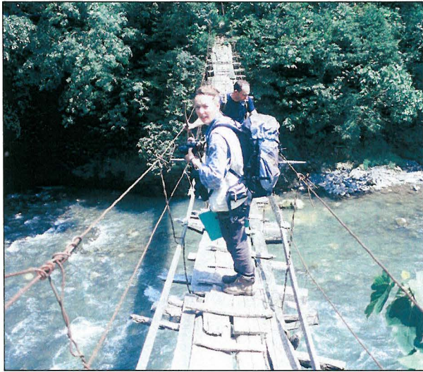
Pont de câbles au-dessus de la rivière Khobikali
