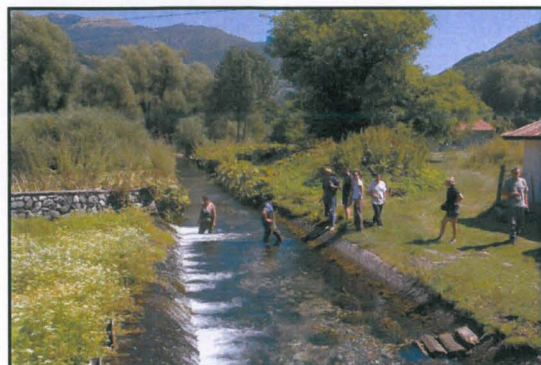
Sources de Treska canalisées
