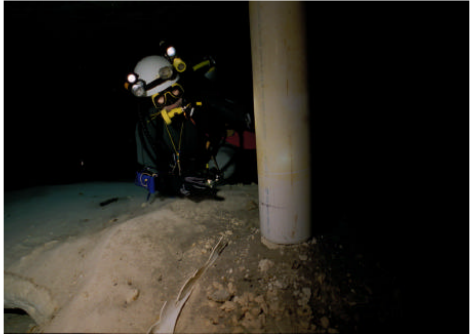
Piloti de béton sous l'hôtel
