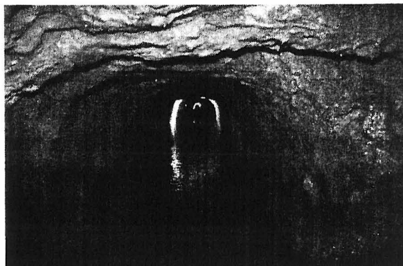
Ph 001 - Galerie de la mine
