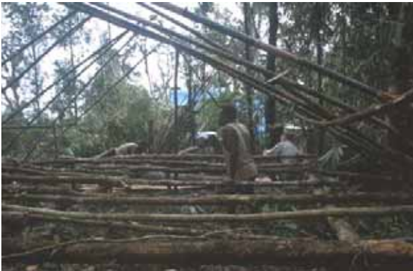
photo n° 7 Charpente des huttes
