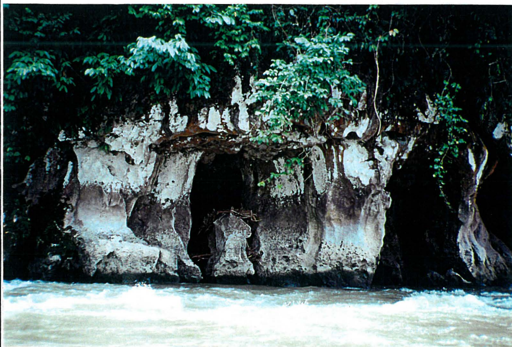
Traces de crue (+4 m) Rive droite de la Batang Hari - Secteur de Gasing -
