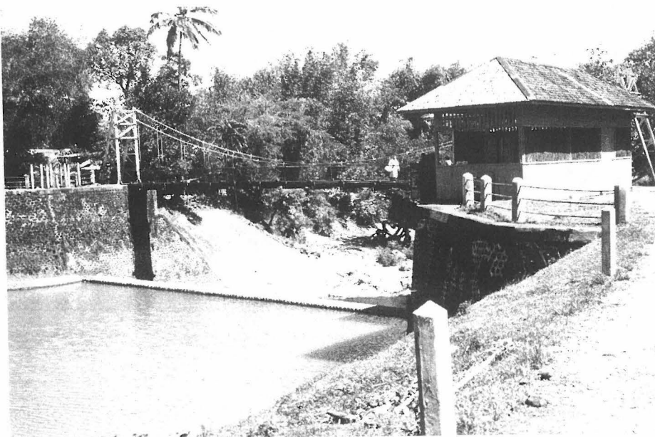
Barrage de Batubassi En rive gauche le poste pluviométrique (Ph. F.Brouquisse)
