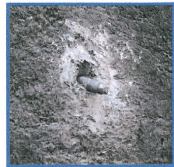
Goujon de 10mm détruit au caillou...
