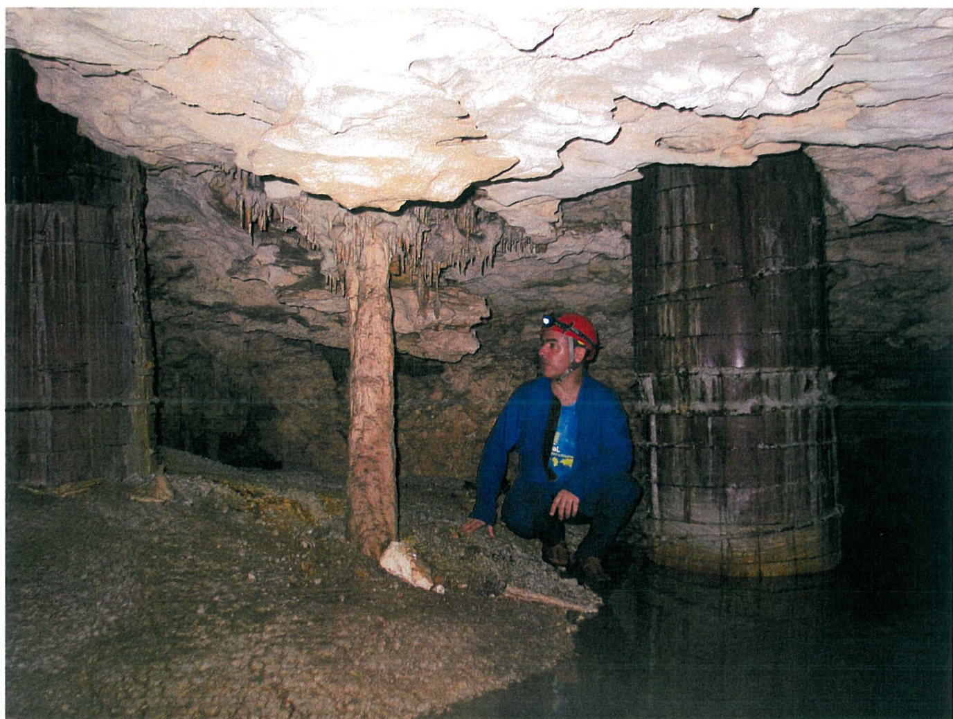
Piliers de soutènement de pont qui traversent la voûte des Aluxes
