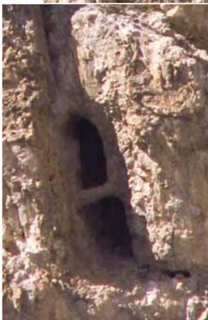
*Détail du confortement par pilier horizontal d'une galerie artificielle :*
