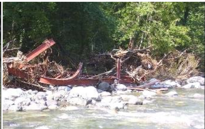
Photos 49 et 50 : Traversée du pont qui n'existait plus ; les restes de la structure métallique en IPN qui tenait le pont, des poutres d'acier de 2 cm d'épaisseur pliées en deux. (DB).
